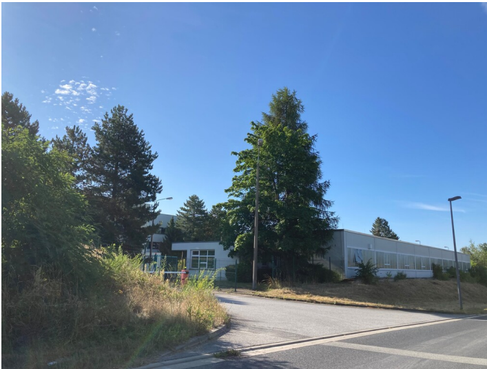
Ehemaliges Heizkraftwerk Bautzen - Verwaltungsgebäude Fotograf/Urheber: Nora Wiedemann
