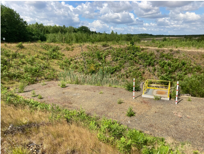
Einlaufbauwerk Hermannsdorfer See Fotograf/Urheber: Nora Wiedemann
