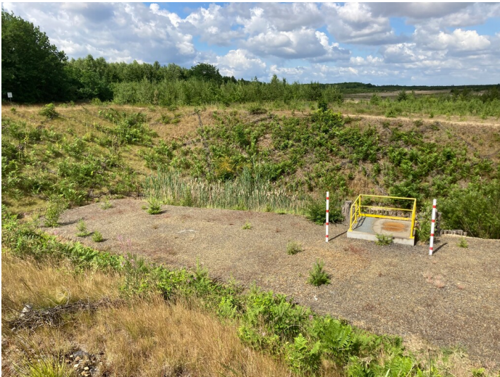
Einlaufbauwerk Hermannsdorfer See Fotograf/Urheber: Nora Wiedemann
