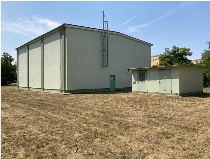
Fernwärmeübergabestation Fotograf/Urheber: Nora Wiedemann
