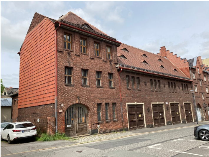
Umformerstation (Gobbinwerk) Fotograf/Urheber: Nora Wiedemann
