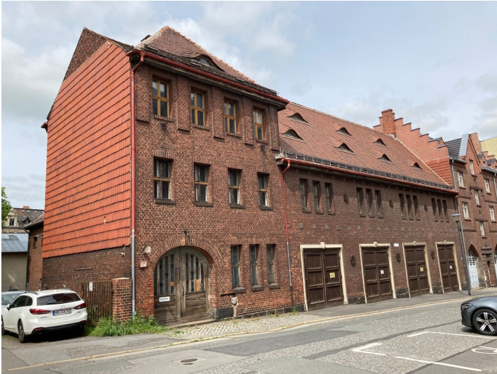
Umformerstation (Gobbinwerk) Fotograf/Urheber: Nora Wiedemann
