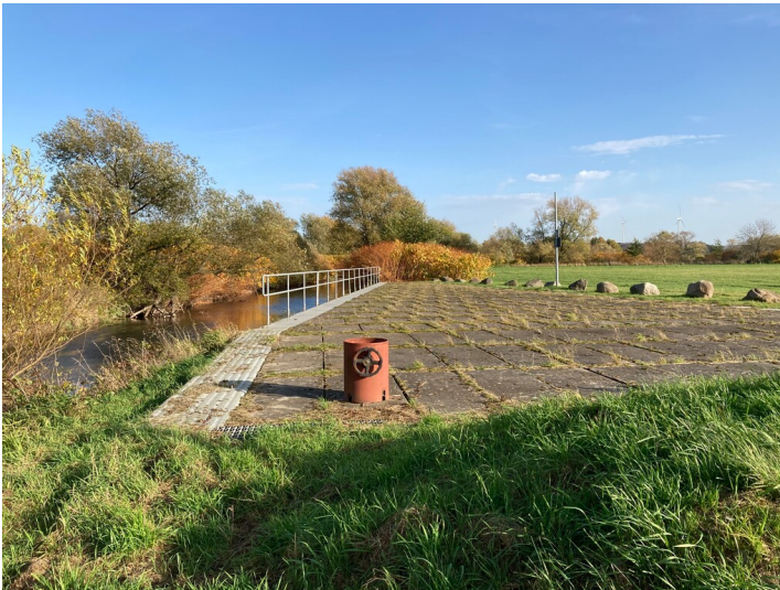
Flutungsanlage für den Berzdorfer See, Entnahmesite an der Neiße Fotograf/Urheber: Nora Wiedemann
