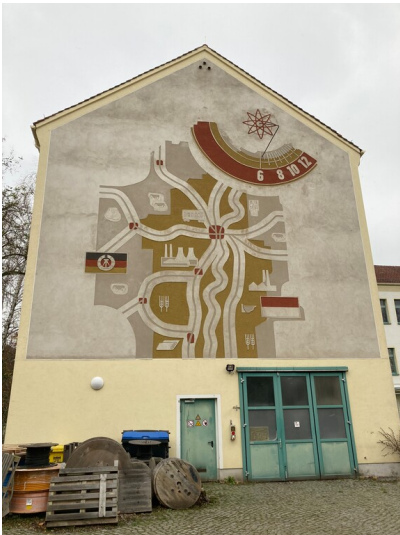
Wandbild am Giebel der Schule Hagenwerder Fotograf/Urheber: Nora Wiedemann
