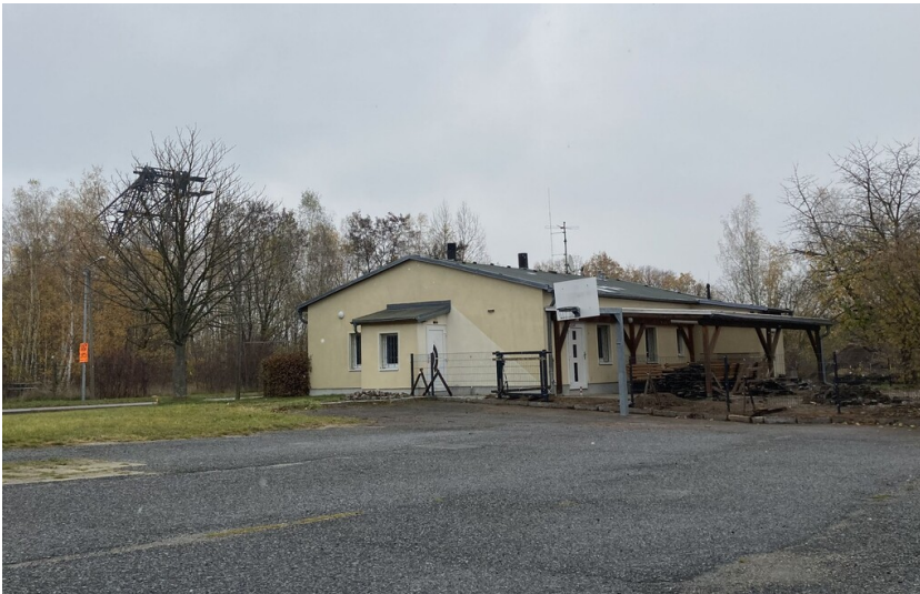
ehemalige Polizeistation des Kraftwerks Hagenwerder Fotograf/Urheber: Nora Wiedemann
