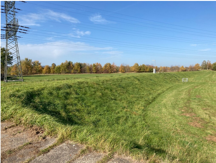
Hochwasserschutzdamm von Hagenwerder Richtung Norden Fotograf/Urheber: Nora Wiedemann
