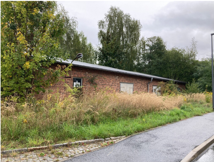
Baracke Zivilverteidigung der Tagesanlagen Tagebau Berzdorf Fotograf/Urheber: Kathrin Krüner
