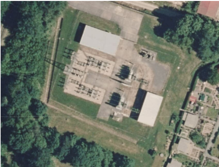
110-kV-Station Görlitz Weinhübel Fotograf/Urheber: Nora Wiedemann
