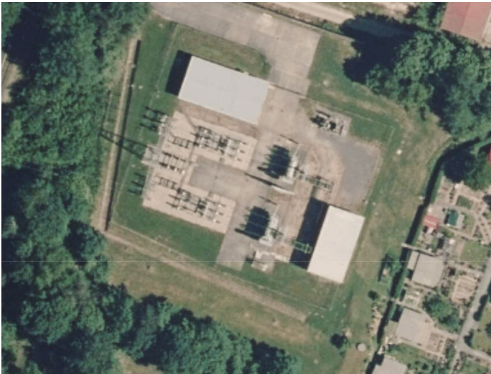
110-kV-Station Görlitz Weinhübel Fotograf/Urheber: Nora Wiedemann
