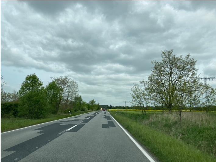
Verlegung der Bundesstraße 99 zwischen Görlitz und Hagenwerder Fotograf/Urheber: Nora Wiedemann
