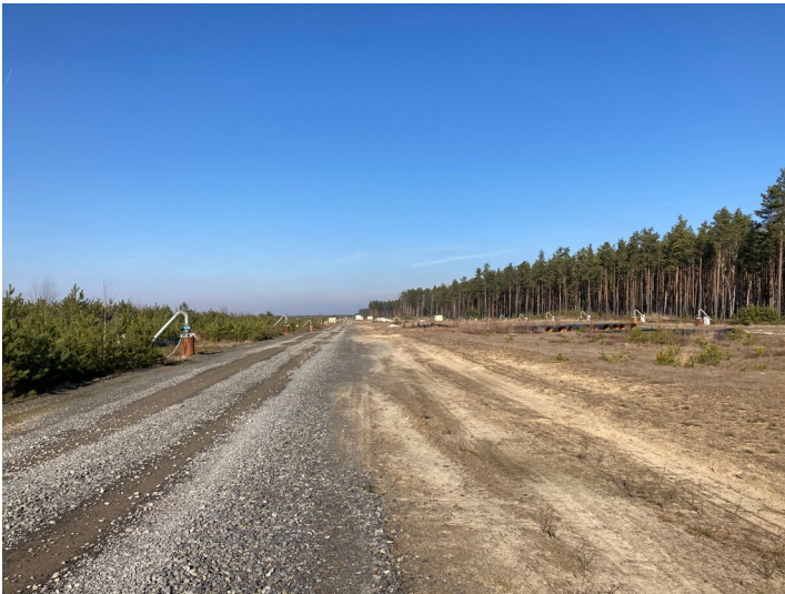
Doppelriegel zur Tagebauentwässerung am Tagebaureichwalde Fotograf/Urheber: Nora Wiedemann
