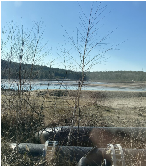
Aschespülstelle des Kraftwerkes Boxberg im Tagebau Reichwalde Fotograf/Urheber: Nora Wiedemann
