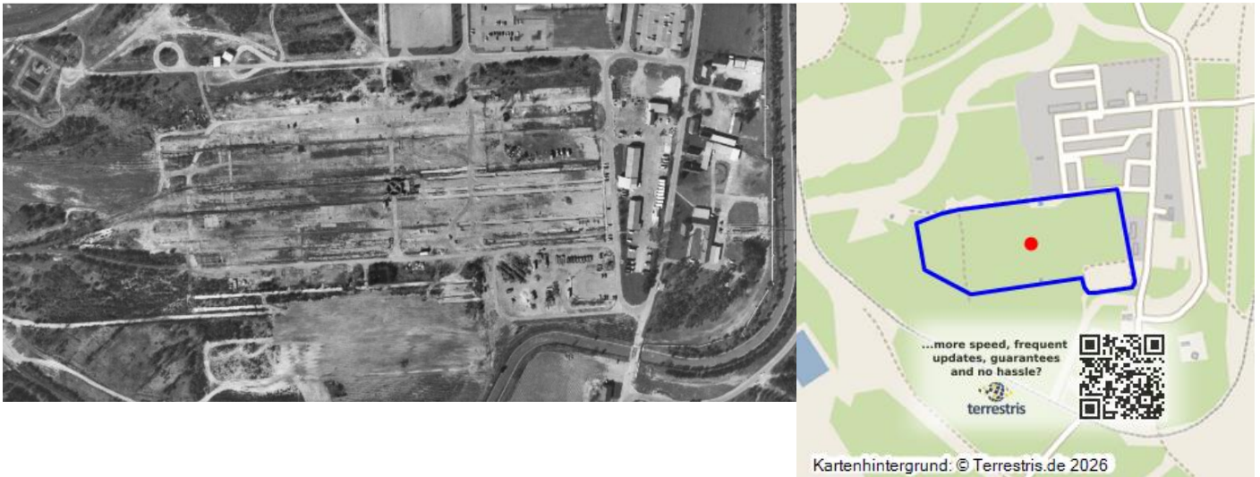
Montageplatz der Tagebaugroßgeräte des Tagebaus Reichwalde Fotograf/Urheber: Nora Wiedemann
