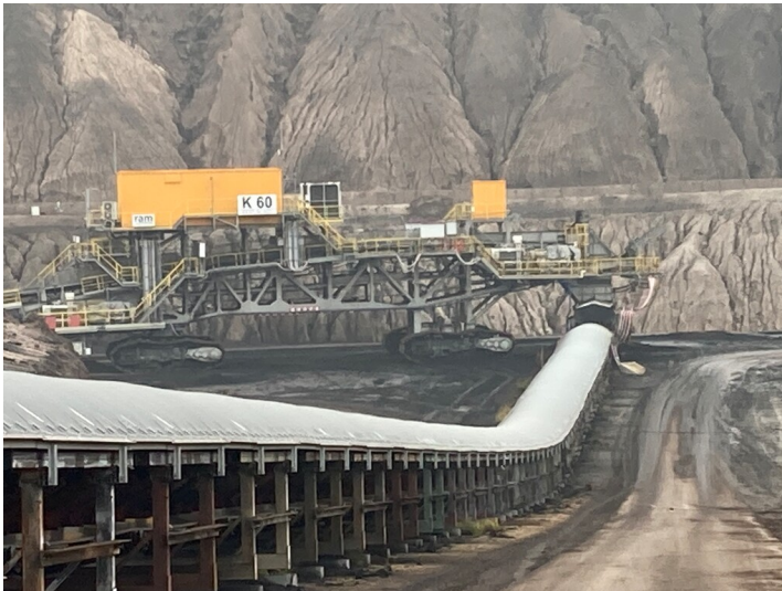
Kohlehauptbandanlage des Tagebaus Nochten Fotograf/Urheber: Tom Pfefferkorn
