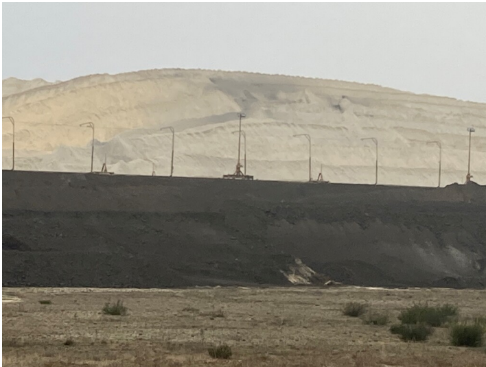
Gipsdepot des Kraftwerkes Boxberg im Tagebau Nochten Fotograf/Urheber: Tom Pfefferkorn
