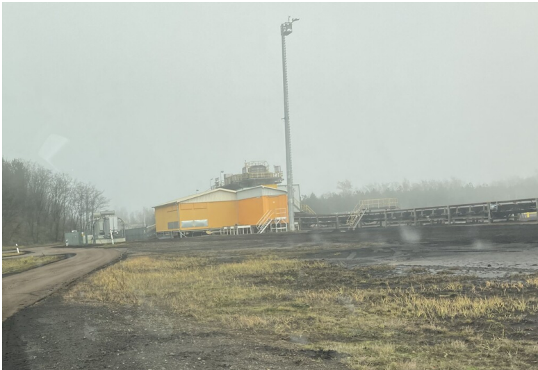
Transformationsstation im Tagebau Nochten Fotograf/Urheber: Nora Wiedemann
