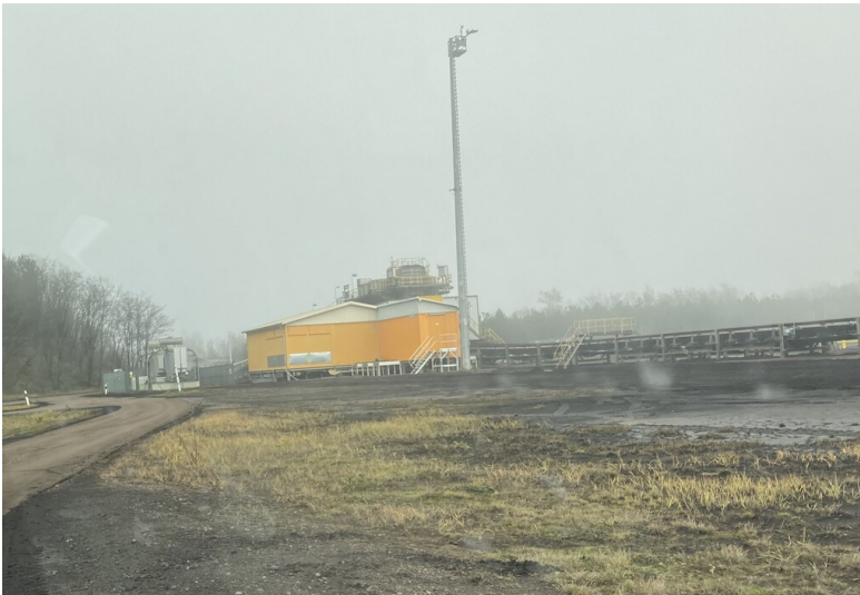
Transformationsstation im Tagebau Nochten Fotograf/Urheber: Nora Wiedemann
