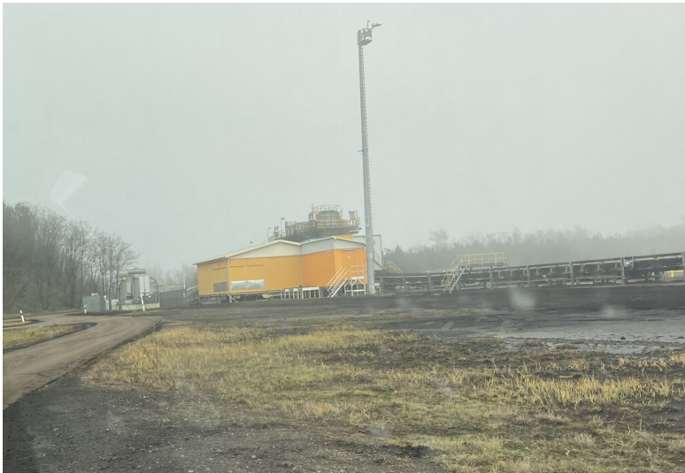
Transformationsstation im Tagebau Nochten Fotograf/Urheber: Nora Wiedemann
