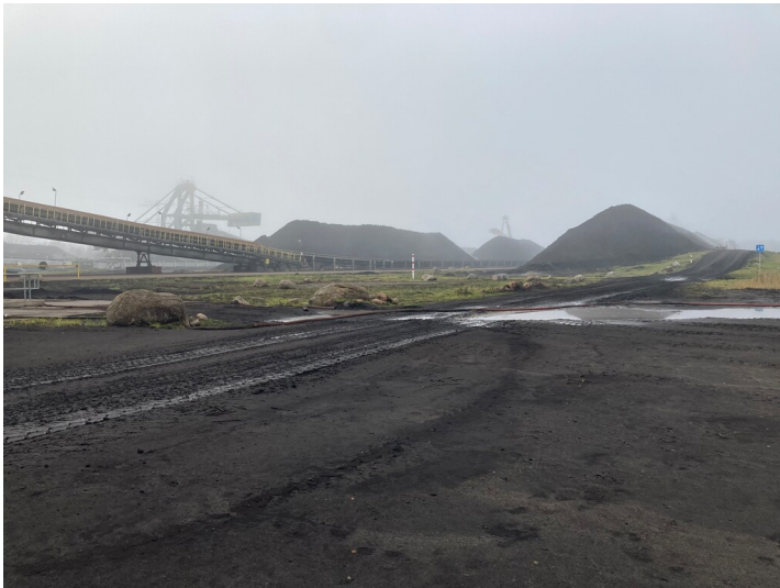
Kohlelagerplatz des Kraftwerkes Boxberg für Kohle aus den Tagebauen Nochten und Reichwalde Fotograf/Urheber: Nora Wiedemann
