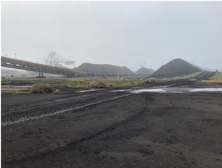
Kohlelagerplatz des Kraftwerkes Boxberg für Kohle aus den Tagebauen Nochten und Reichwalde Fotograf/Urheber: Nora Wiedemann
