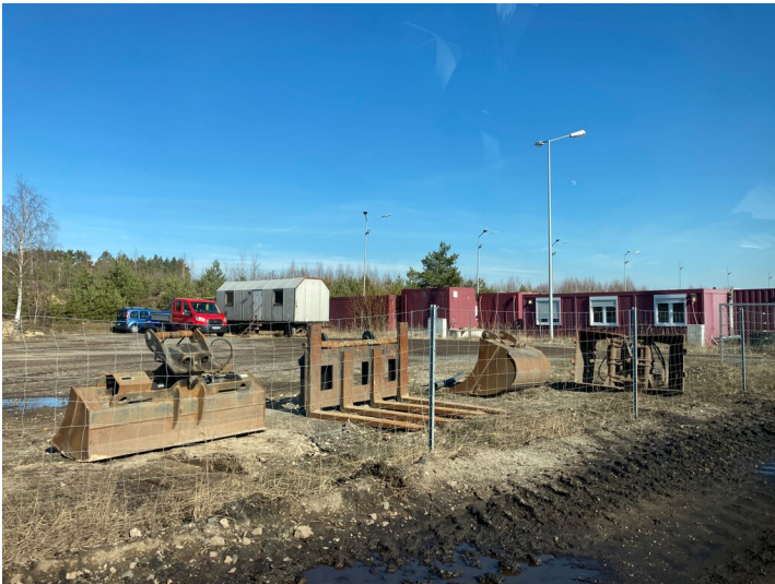
Tagesanlagen des Tagebaus Reichwalde Fotograf/Urheber: Nora Wiedemann
