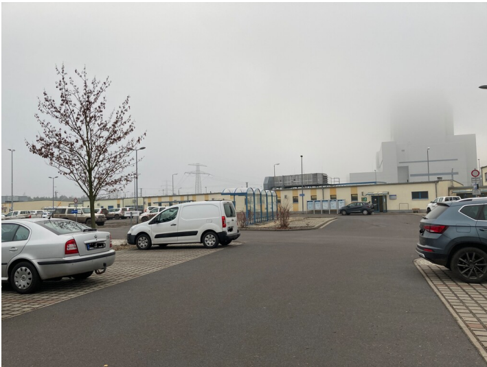
Waschkaue für den Tagebau Nochten/Reichwalde Fotograf/Urheber: Nora Wiedemann
