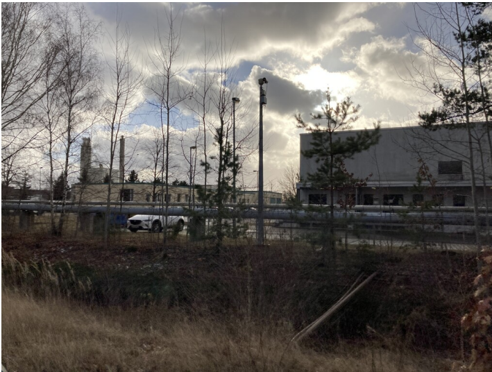
Großraumwasserkessel mit Braunkohlestaubbrenner Fotograf/Urheber: Nora Wiedemann
