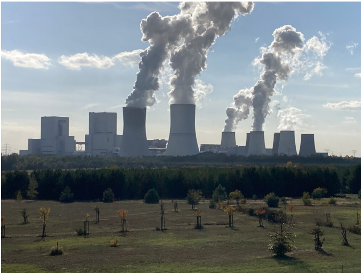
Kraftwerk Boxberg Fotograf/Urheber: Tom Pfefferkorn
