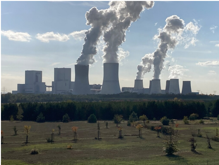
Kraftwerk Boxberg Fotograf/Urheber: Tom Pfefferkorn
