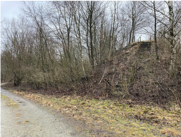
Immissionschutzbauwerk für das Dorf Mühlrose Fotograf/Urheber: Matin Neubacher
