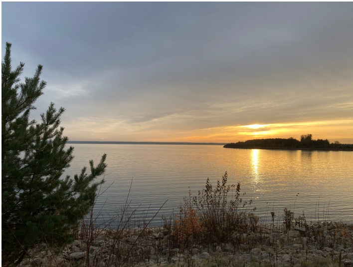
Speicherbecken Bärwalder See Fotograf/Urheber: Nora Wiedemann
