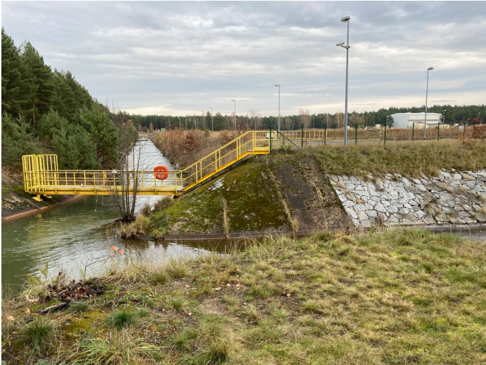
Grubenwasserbehandlungsanlage zur Reinigung und zum Abschlag des Sumpfungswassers aus dem Tagebau Reichwalde. Fotograf/Urheber: Nora Wiedemann
