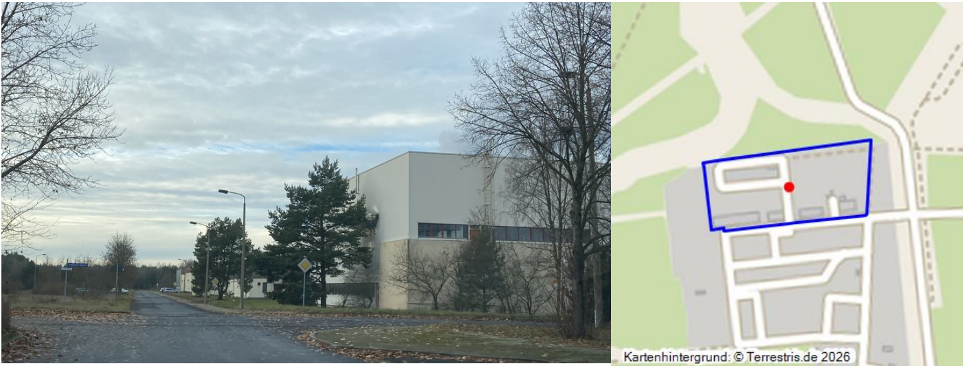
Ehemalige Werkstatt des Tagebaus Reichwalde Fotograf/Urheber: Nora Wiedemann
