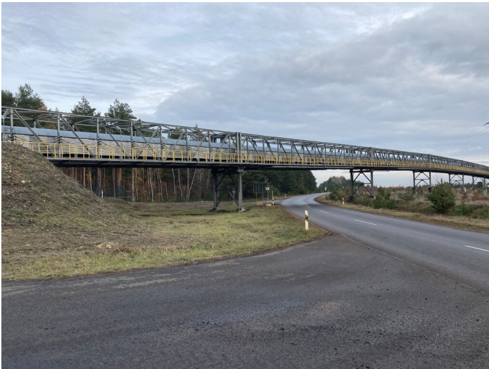
Kohlebandanlage des Tagebaus Reichwalde außerhalb des Abbaufeldes Fotograf/Urheber: Nora Wiedemann
