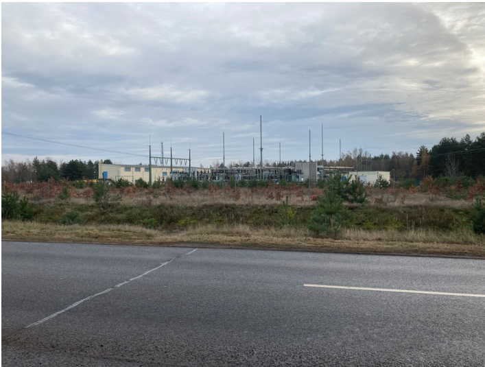
Umspannwerk für den Tagebauteil Reichwalde Fotograf/Urheber: Nora Wiedemann
