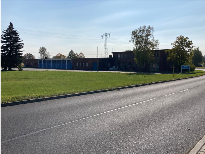
Kraftwerk Hagenwerder - Nebengebäude Fotograf/Urheber: Tom Pfefferkorn
