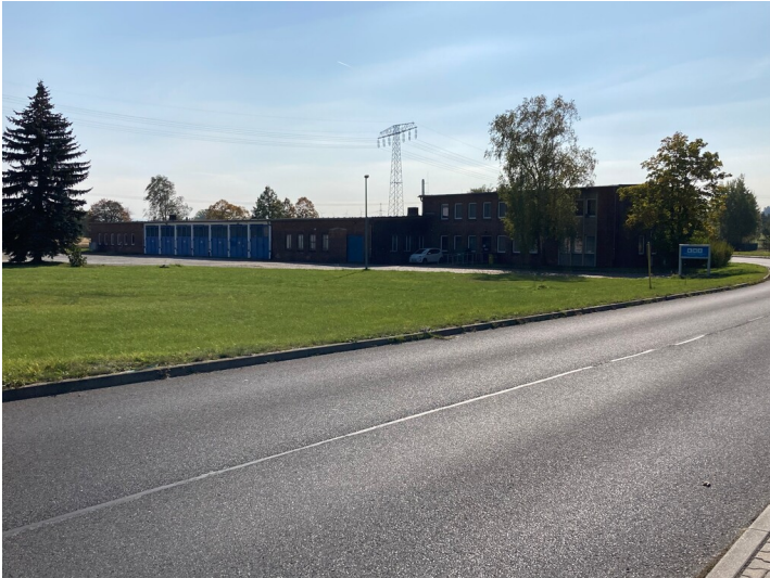
Kraftwerk Hagenwerder - Nebengebäude Fotograf/Urheber: Tom Pfefferkorn
