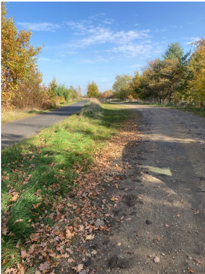
Dichtwand zwischen der Neiße und dem Tagebau Berzdorf Fotograf/Urheber: Nora Wiedemann
