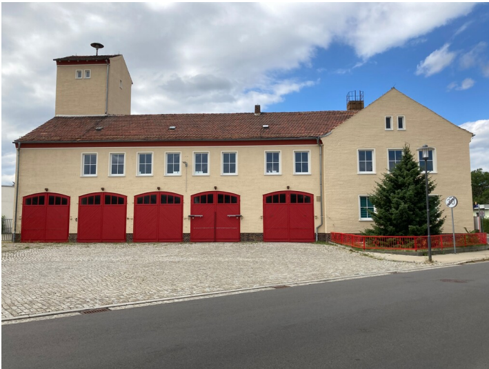
Feuerwache Fotograf/Urheber: Nora Wiedemann
