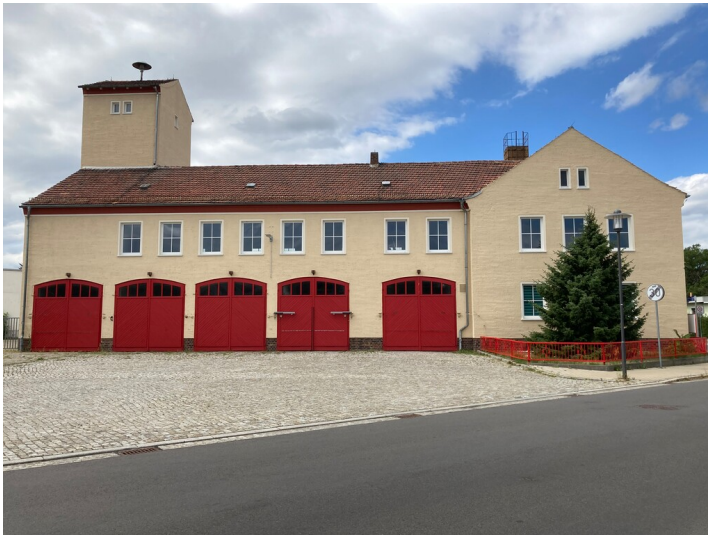
Feuerwache Fotograf/Urheber: Nora Wiedemann
