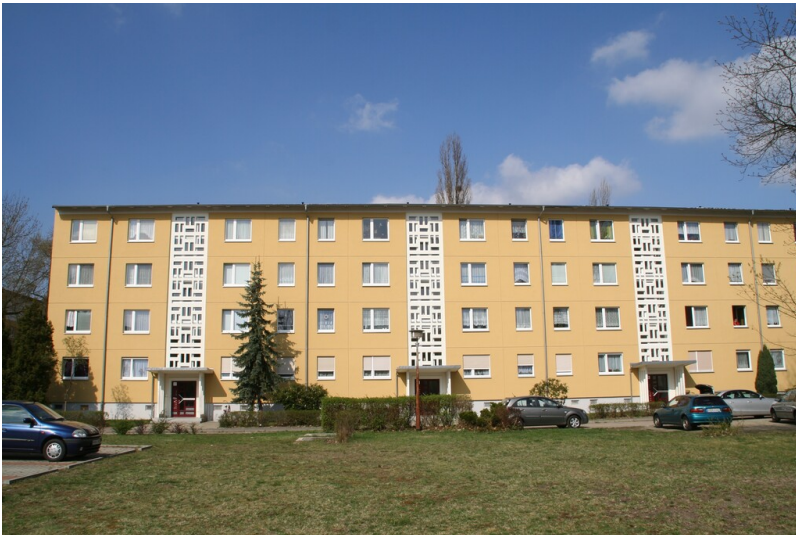
Wohnblock Sputnikstraße im Wohnkomplex VI Fotograf/Urheber: Nora Wiedemann
