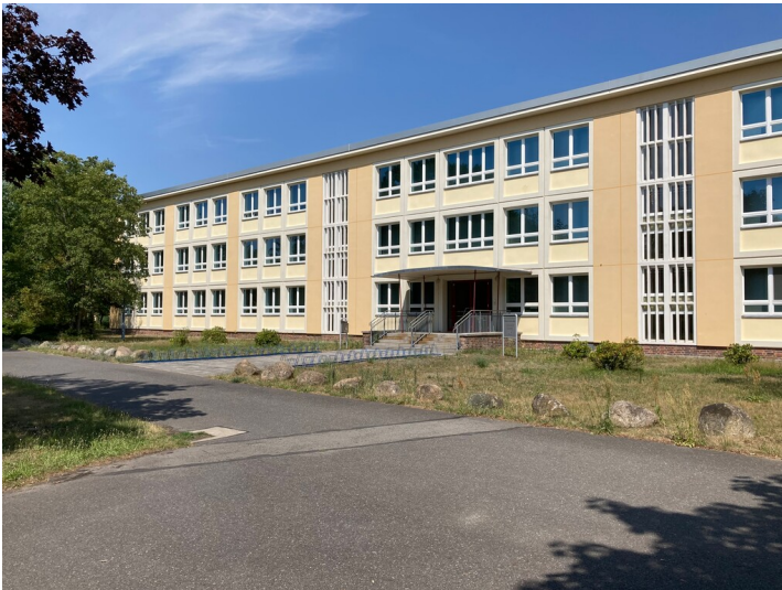
Ehemalige Polytechnische Oberschule WK IV Fotograf/Urheber: Nora Wiedemann
