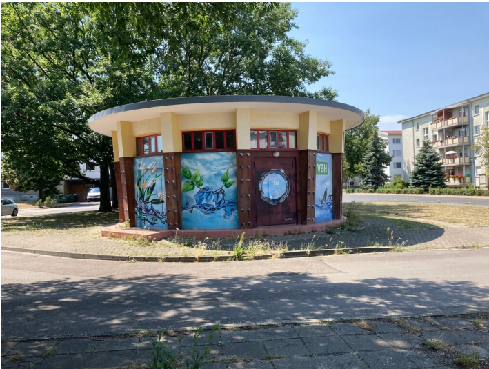
Abwasserpumpstation Wohnkomplex VII Fotograf/Urheber: Nora Wiedemann
