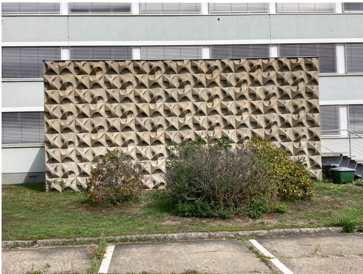
Rechenzentrum für das Gaskombinat Schwarze Pumpe Fotograf/Urheber: Tom Pfefferkorn
