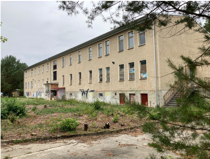
Ehemalige Tagesanlagen des Tagebau Scheibe Fotograf/Urheber: Matin Neubacher
