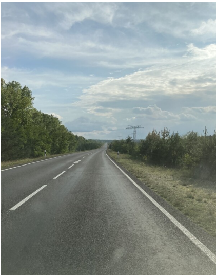
Umverlegung der Bundesstraße 97 um den Tagebau Spreetal Fotograf/Urheber: Nora Wiedemann
