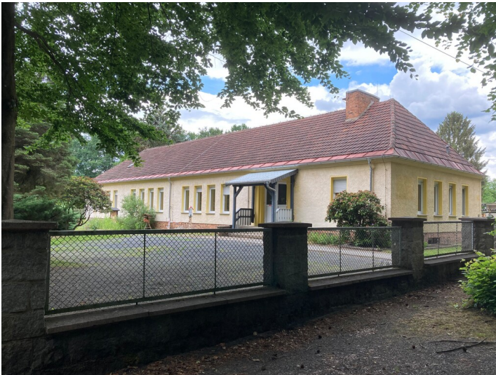
Kindergarten der Werksiedlung Heide Fotograf/Urheber: Nora Wiedemann
