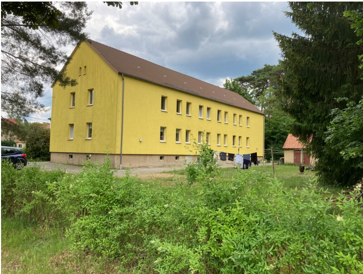
Mehrfamilienwohnhaus der Werksiedlung Heide Fotograf/Urheber: Nora Wiedemann
