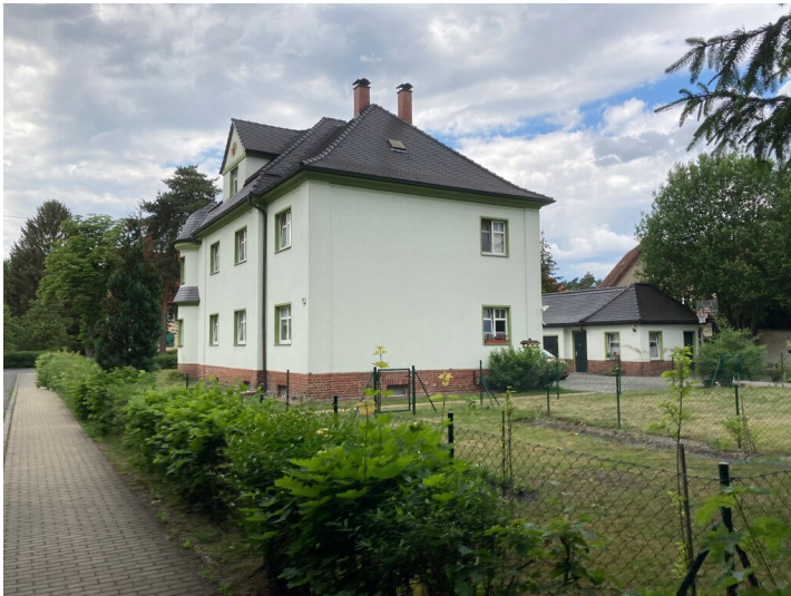
Wohnhaus Bahnhofstraße 30 der Werksiedlung Heide Fotograf/Urheber: Nora Wiedemann
