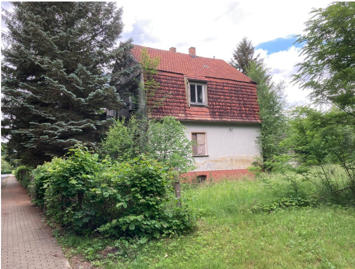
Wohnhaus Bahnhofstraße 26 der Werksiedlung Heide Fotograf/Urheber: Nora Wiedemann
