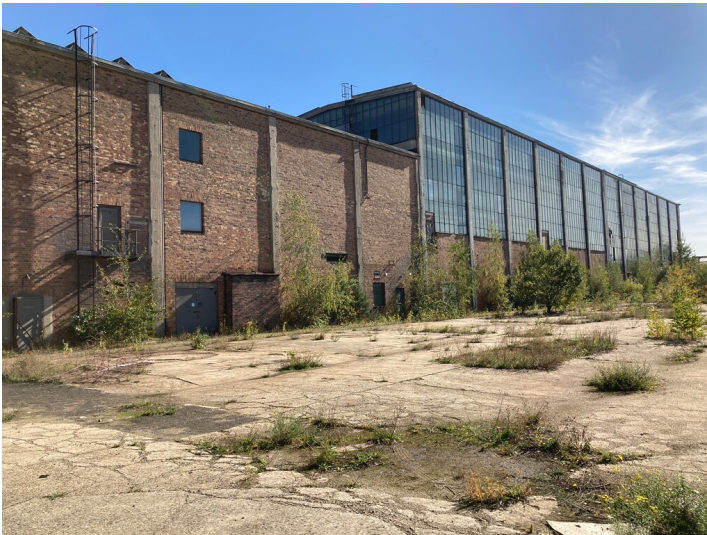
Maschinenhaus Strang Fotograf/Urheber: Matin Neubacher
