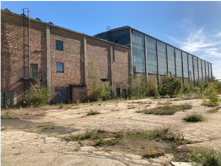
Maschinenhaus Strang Fotograf/Urheber: Matin Neubacher
