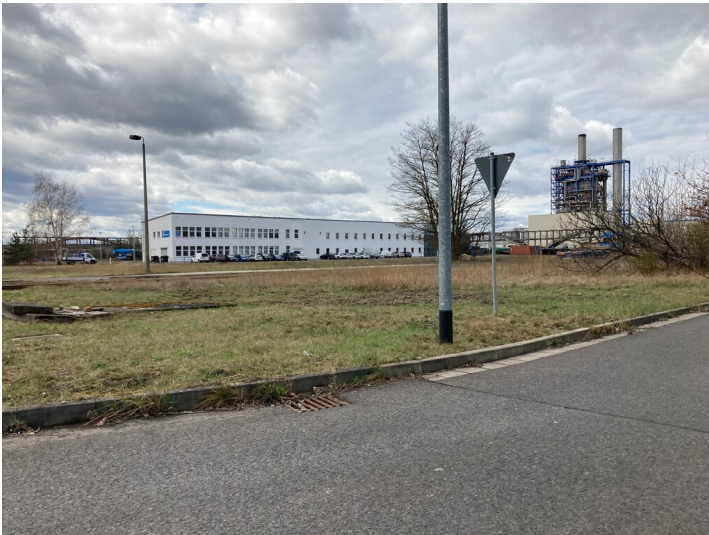
Zentrale Messwarte Fotograf/Urheber: Matin Neubacher
