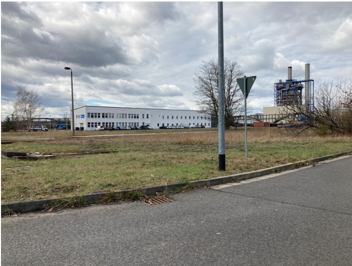
Zentrale Messwarte Fotograf/Urheber: Matin Neubacher
