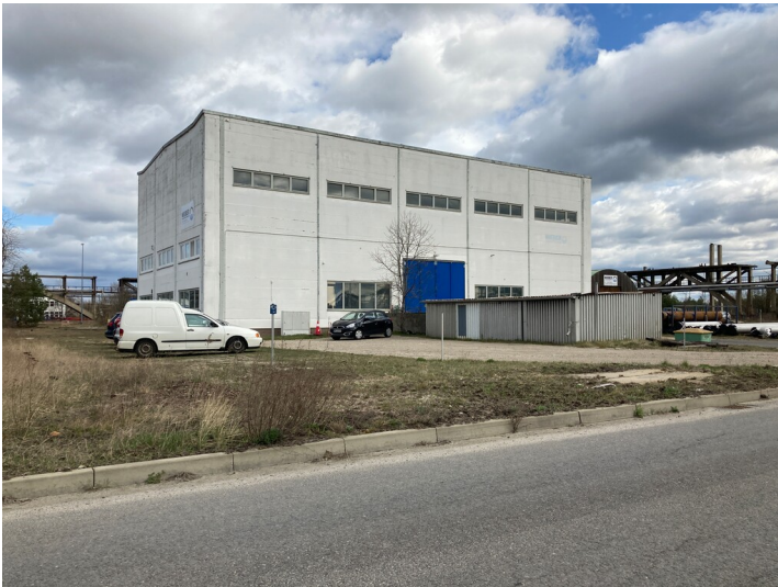
Rohrleitungsbau Fotograf/Urheber: Matin Neubacher
