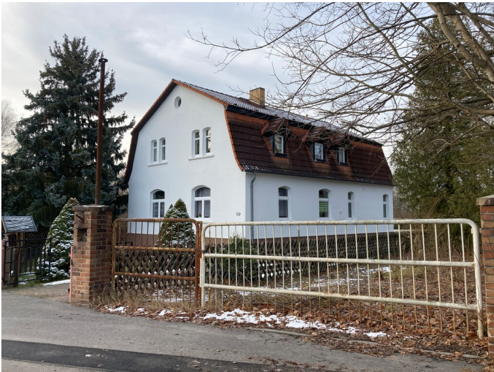
Die Direktorenvilla der ehemaligen Gasanstalt von Weißwasser Fotograf/Urheber: Nora Wiedemann
