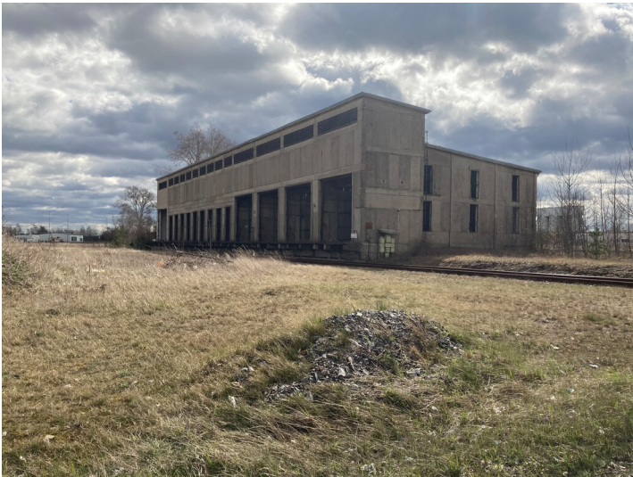
30 kV-Station Generatorenhaus Fotograf/Urheber: Nora Wiedemann
