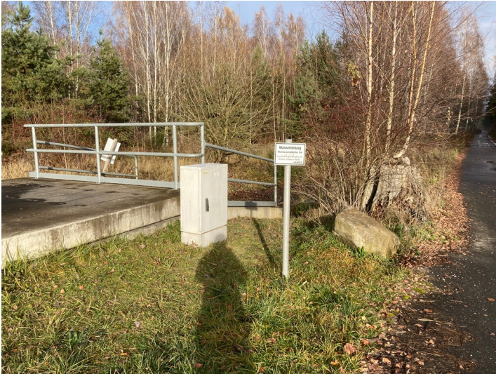
Klarwasserableiter Ost Fotograf/Urheber: Nora Wiedemann
