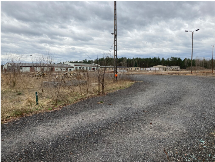
Ehemalige Wohnbaracken für den Aufbau des Gaskombinates Schwarze Pumpe Fotograf/Urheber: Nora Wiedemann
