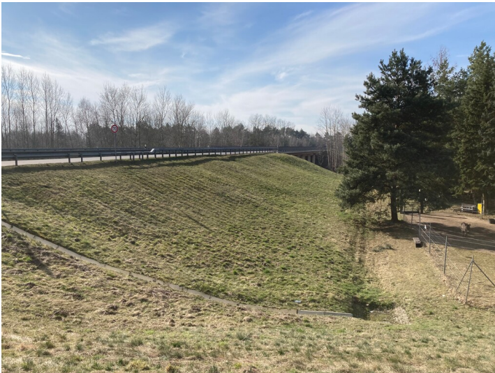
Umverlegung der B 156 Fotograf/Urheber: Nora Wiedemann
