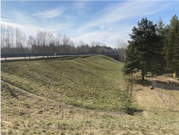
Umverlegung der B 156 Fotograf/Urheber: Nora Wiedemann
